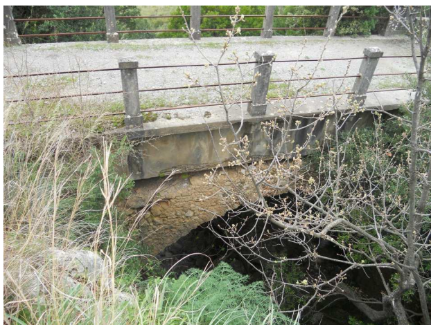
Figura 2 - Arco Romano malamente ricoperto
